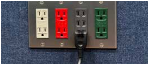
白 音響用 200V → 100V、赤 音響用 200V → 117V、黒 雑電用 100V、緑 PC 用 100V → 117V
