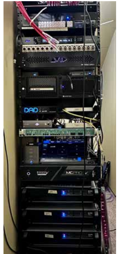
1st と 2st の間にラックを設置
